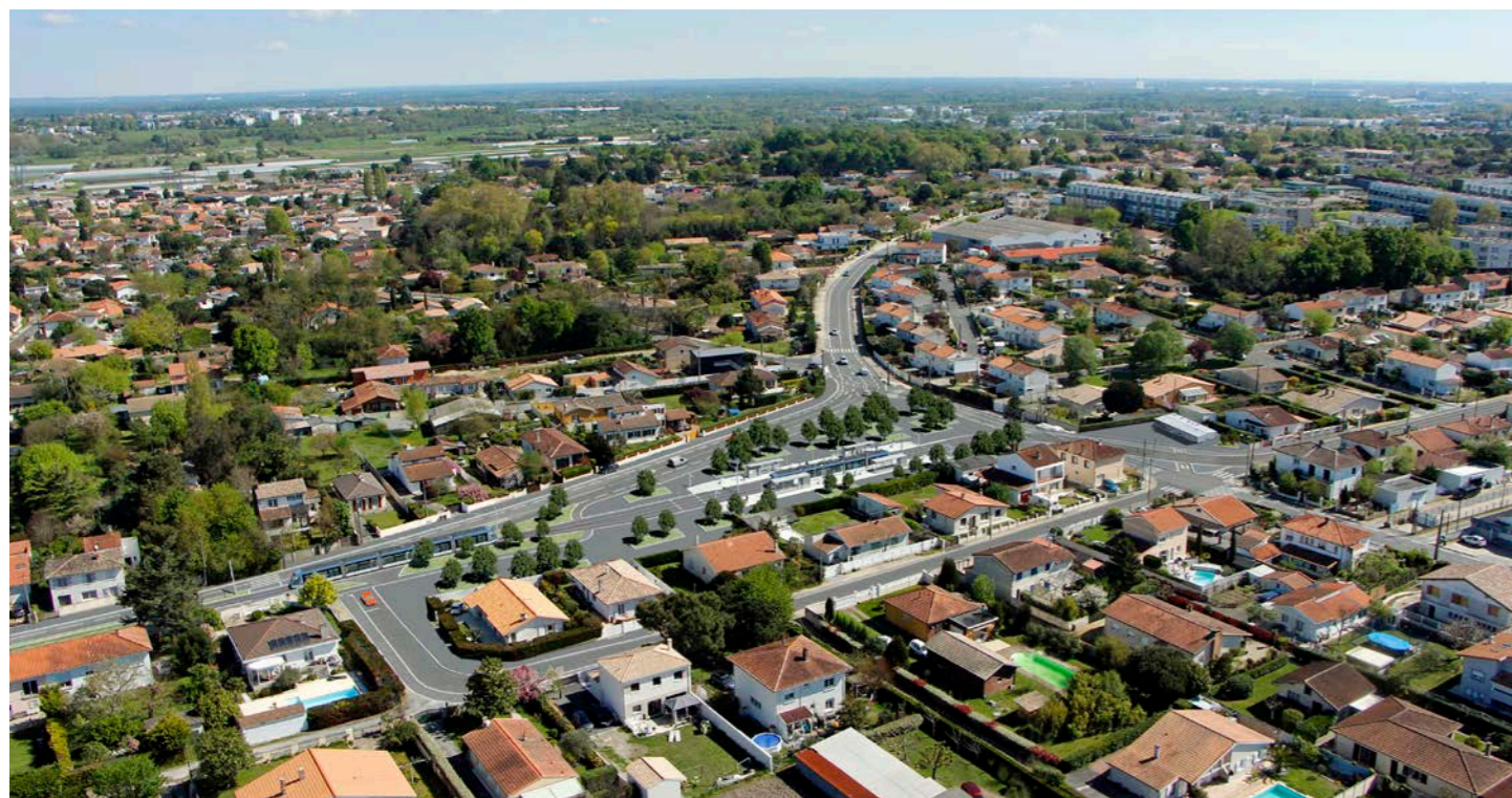
EYSINES - AVENUE DE PICOT - RUE DU ROUGE - LIGNE D - LE TRAMWAY DE BORDEAUX MÉTROPOLÉ ©
