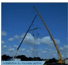
Installation du nouveau pylône
