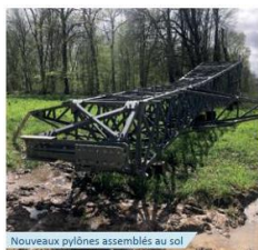
Nouveaux pylônes assemblés au sol
